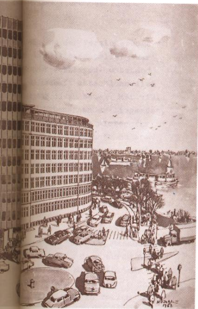
Die Hauptverwaltung am Alsterufer: das erste eigene Direktionsgebäude der Hamburg-Mannheimer. Die Zeichnung stammt aus dem Jahr 1963.
